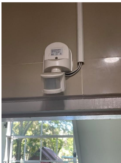
ติดตั้งระบบเซนเซอร์แสงสว่างภายในห้องน้ำ
