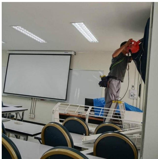
มีการบำรุงรักษาเครื่องปรับอากาศให้มีสภาพการทำงานให้เต็มประสิทธิภาพ
