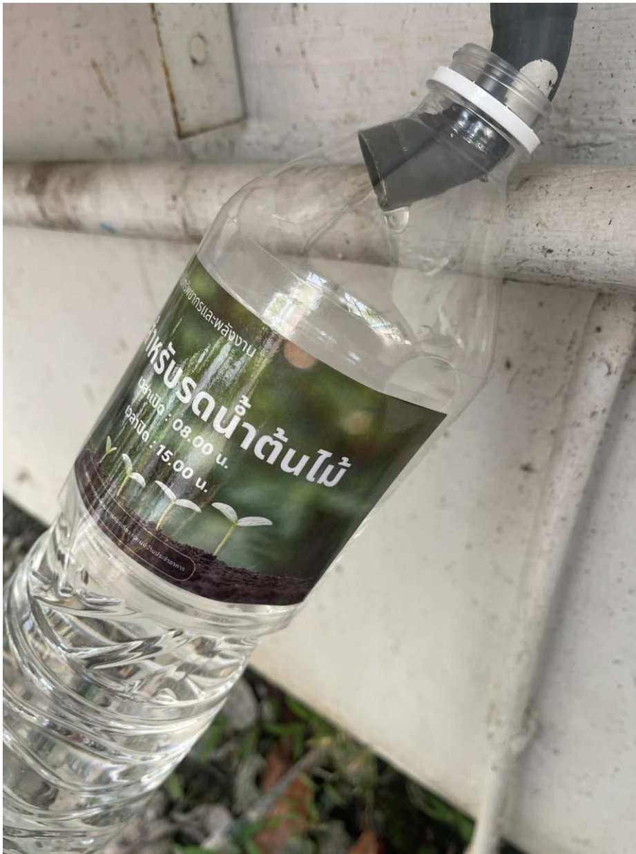
น้ำที่ได้จากน้ำทิ้งเครื่องปรับอากาศ
