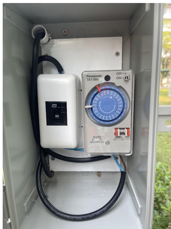
ติดตั้งระบบปิด-เปิด แสงสว่างภายนอกอาคาร
