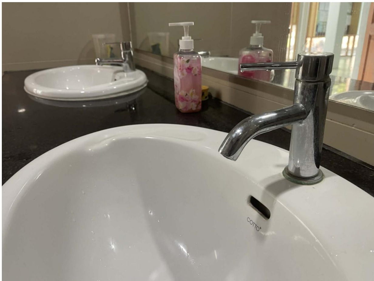
รูปภาพเปลี่ยนอุปกรณ์ก๊อกน้ำแบบประหยัดน้ำทดแทนของเดิม
