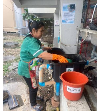
ภาพที่ 4.2.1 ภาพถังดักไขมัน และการล้างทำความสะอาด
