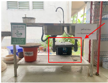
ภาพที่ 4.2.1 ภาพถังดักไขมัน และการล้างทำความสะอาด
