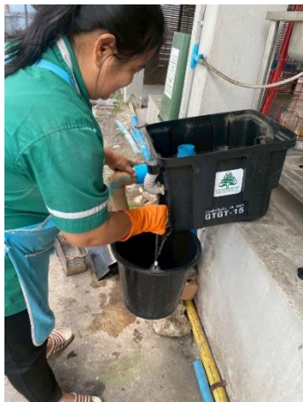
ภาพที่ 4.2.12 พนักงานทำความสะอาดถังดักไขมัน
