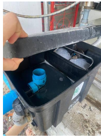
ภาพที่ 4.2.13 การตรวจสอบถังดักไขมัน
