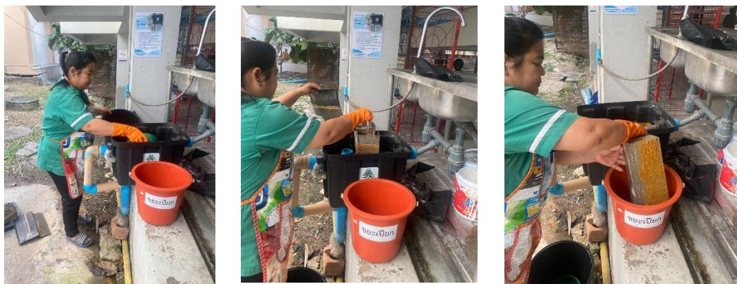
ภาพที่ 4.2.5 ภาพถังดักไขมัน และการล้างทำความสะอาด
