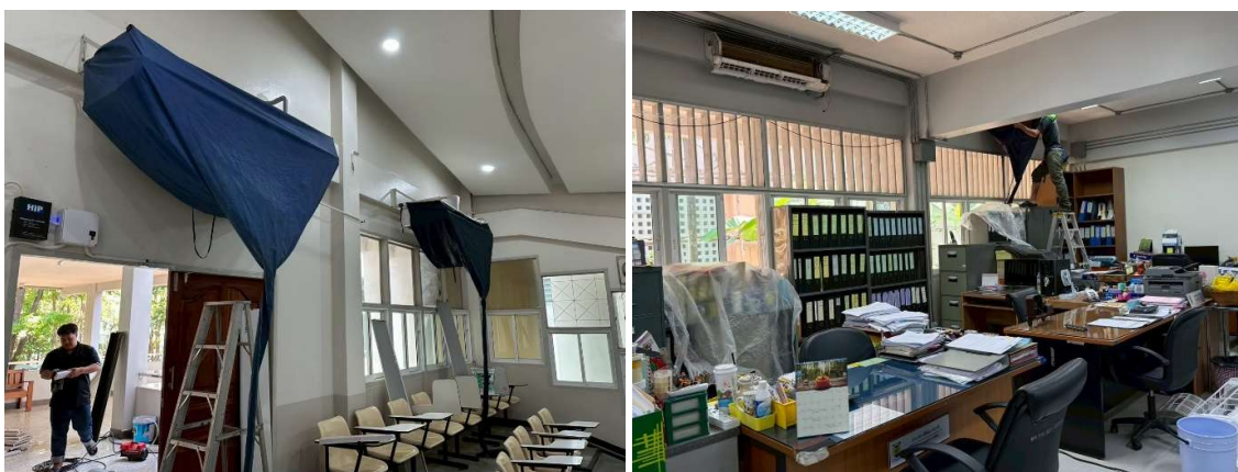
กิจกรรมทำความสะอาดเครื่องปรับอากาศ โดยบริษัท วันที่ 7 กันยายน 2568
