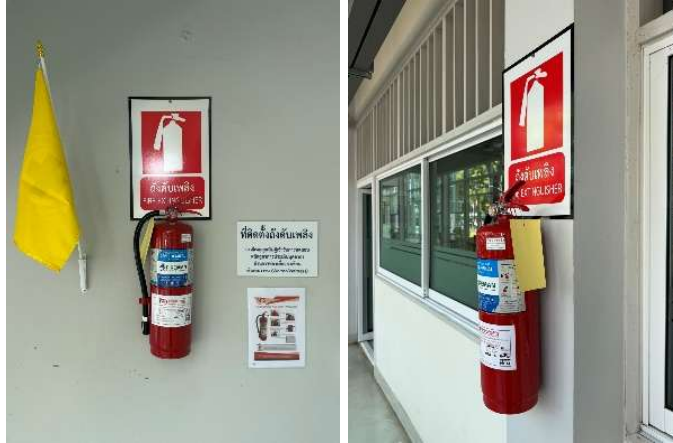
การติดตั้งถังดับเพลิง ณ บริเวณชั้น 1
