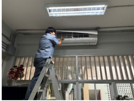
การทำความสะอาดไส้กรองแอร์โดยบุคลากรคณะพัฒนาการท่องเที่ยว (วันที่ 1 มีนาคม 2567)
